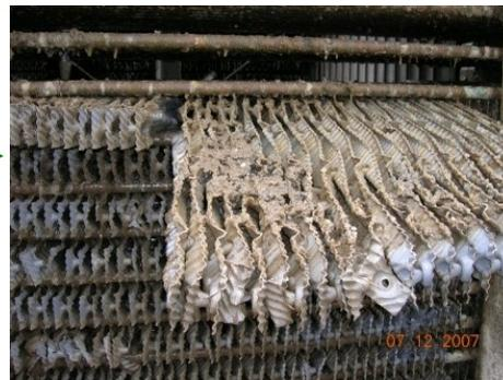
充填材を引き抜いたところ。充填材の上面にスケールが軟化して発生したと思われる多量の泥状の物質を確認した。
